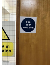
Fire door signage
