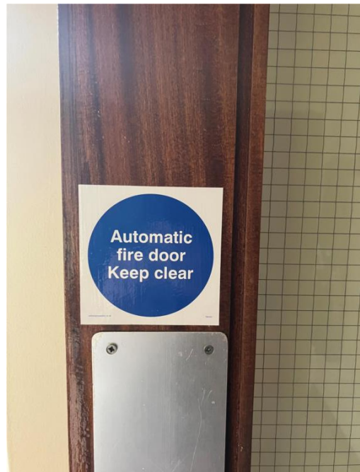
Automatic fire door sign
