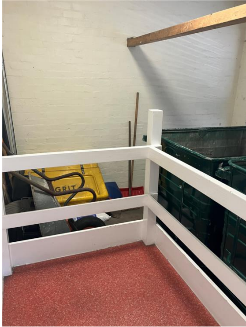
Edge protection bin store
