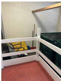
Edge protection bin store
